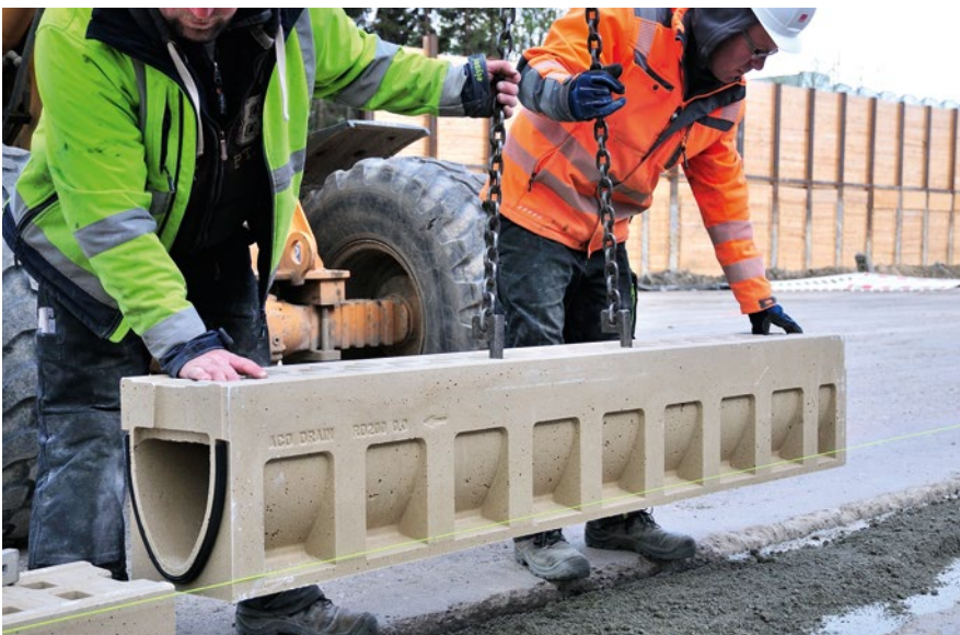
Das geringe Gewicht der 2-m-Elemente aus Polymerbeton ermöglicht eine Verlegung mit leichten Hebermaschinen.
