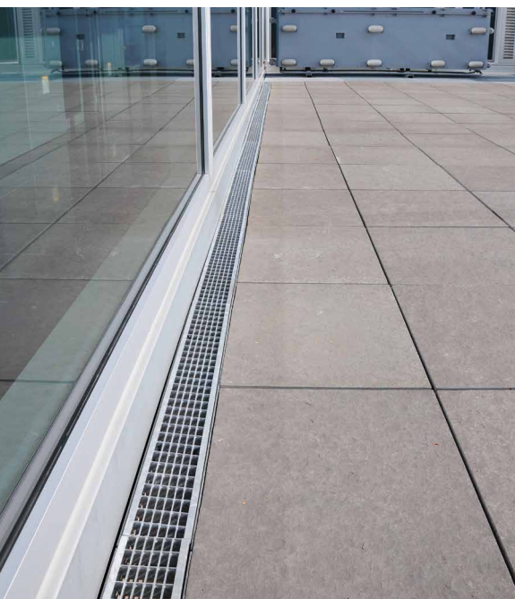
Zur sicheren Ableitung des anfallenden Regenwassers wurde an der Fassade eine Entwässerungsrinne vom Typ ACO DRAIN® Multiline V 100 S Flachrinne installiert.
