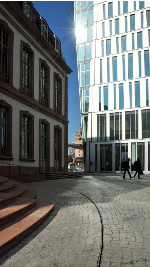
Von der ACO DRAIN® Multiline V 100 S Entwässerungsrinne ist lediglich der Schlitz des Aufsatzes zu sehen. Eine Verlegung der Rinne ist auch in Anpassung an den Fassadenverlauf möglich.
