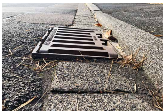
Aufsätze sollten bündig mit der Straßenoberfläche eingebaut sein.
