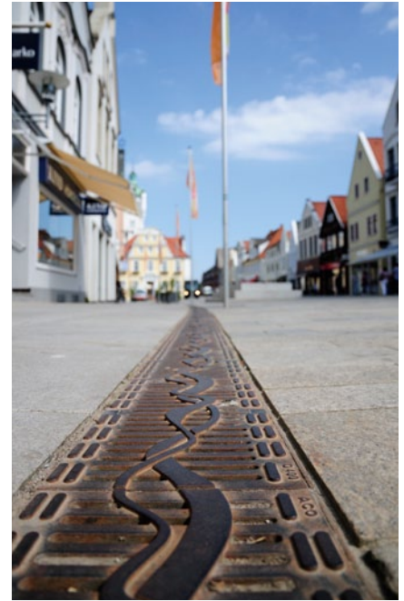
Die neue Entwässerung der Freifläche mit der ACO DRAIN® Multiline V 200 G endet direkt am Rathaus in Verden
