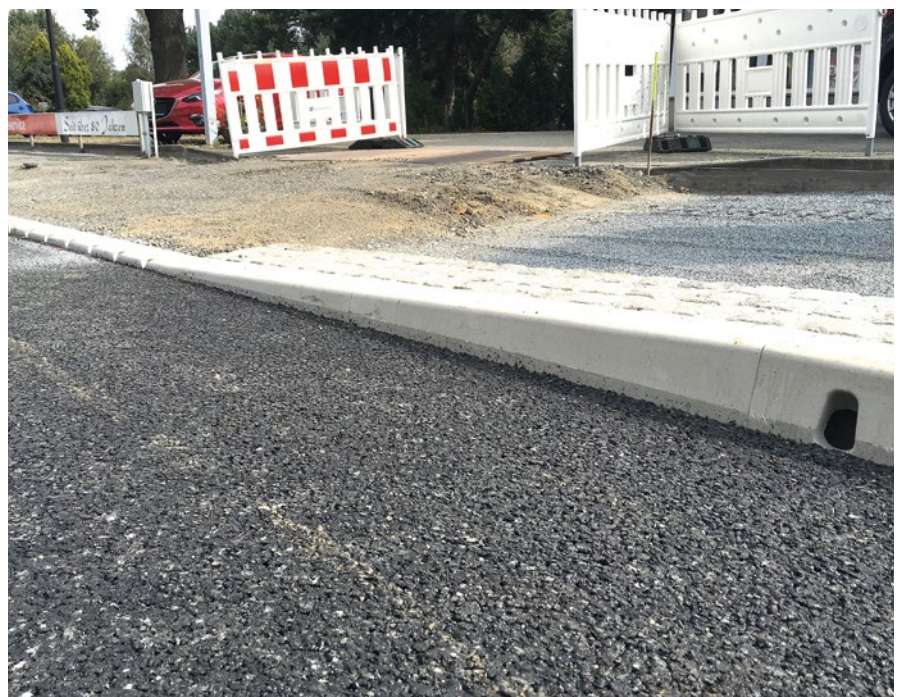
Im Bereich von Grundstücksauffahrten erfolgt die Bordsteinabsenkung durch 2-teilige Absenksteine über eine Länge von 2,0 m
