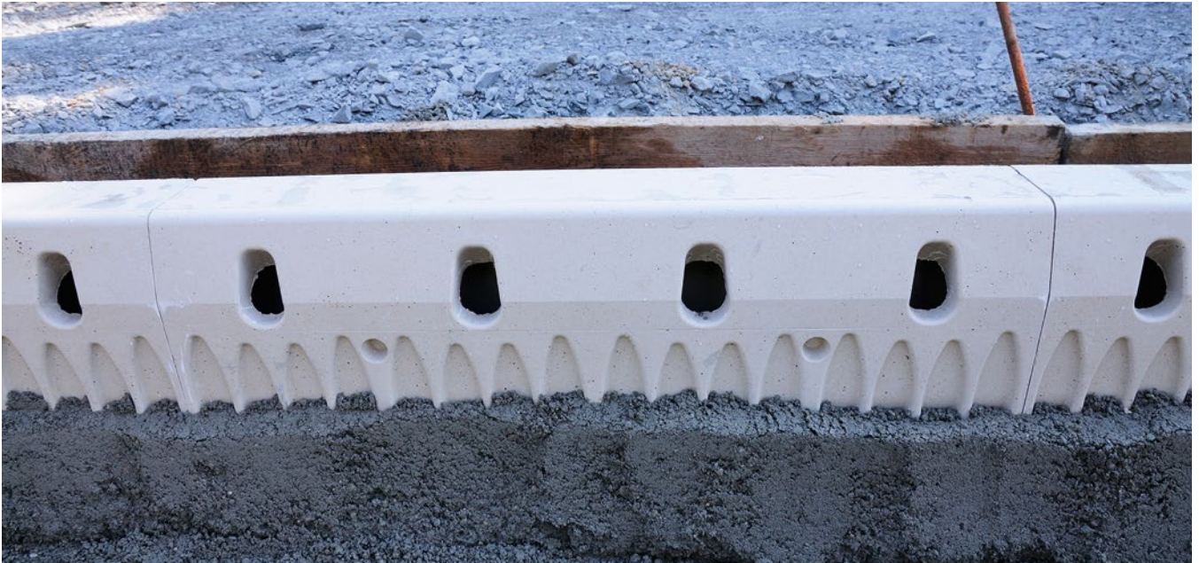
Das 1 m lange Element verfügt über einen Einlaufquerschnitt von 147 cm 2
